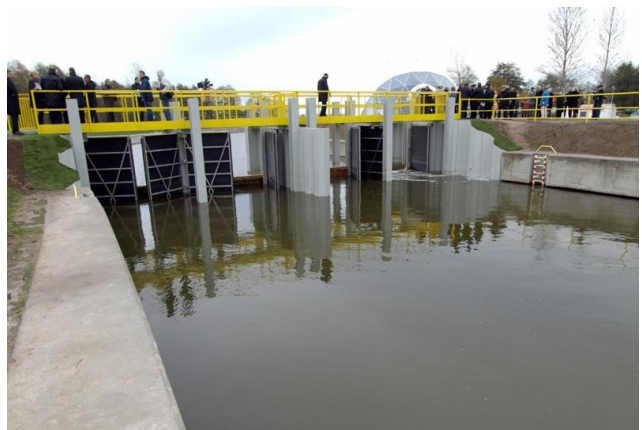
Ryc. 6. Wrota przeciwsztormowe na Kanale Jamneńskim ( http://www.gk24.pl/wiadomosci/koszalin/art/4577817,wrota-sztormowe-na-kanale-jamnejskim-gotowe-zdjecia,id,t.html )
