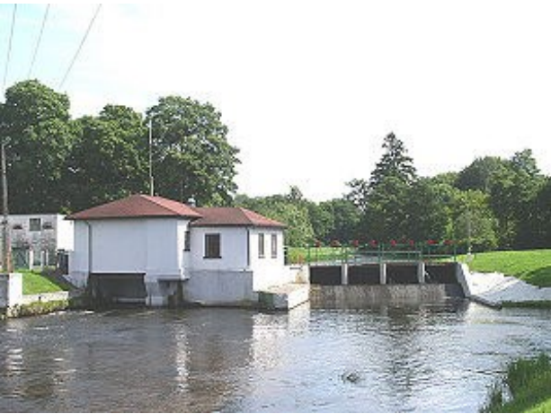
Ryc. 1. Mała Elektrownia Wodna na rzece Łupawa w miejscowości Smołdzino
